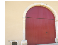
Ancienne porte de grange, réutilisée en garage : porte de garage basculante à lames verticales et imposte fixe en bois.
